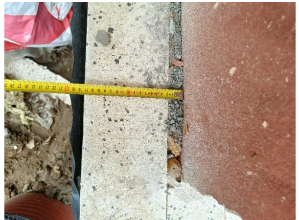
6 pav. Atliekami pamatų apšiltinimo darbai, pamatai apšiltinami 15 cm polistireninio putplasčio sluoksniu, įrengiama drenažinė membrana.
