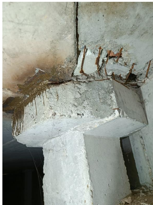
24 pav. Trikampės plokštės betono pažaidos ties kolonos atrama.
