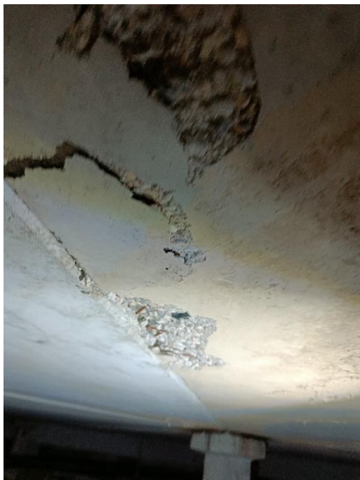
23 pav. Vietomis užfiksuotas pažeistas perdangos plokščių apsauginis betono sluoksnis.
