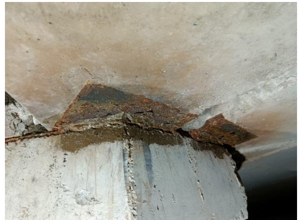
14 pav. Vietomis užfiksuota kolonų ir perdangos plokščių jungimo plokštelių korozija.
