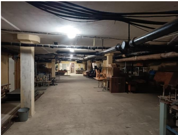
13 pav. Bendras kolonų vaizdas.
