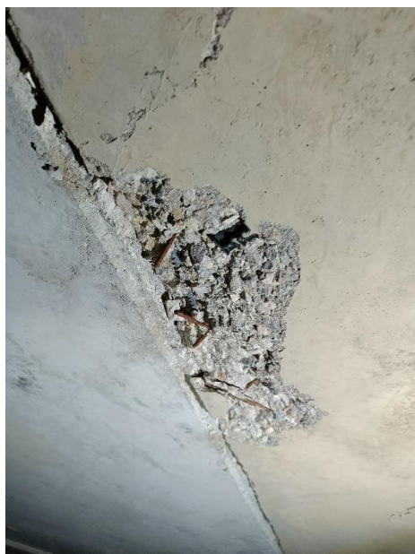
21 pav. Vietomis užfiksuotas pažeistas perdangos plokščių apsauginis betono sluoksnis.
