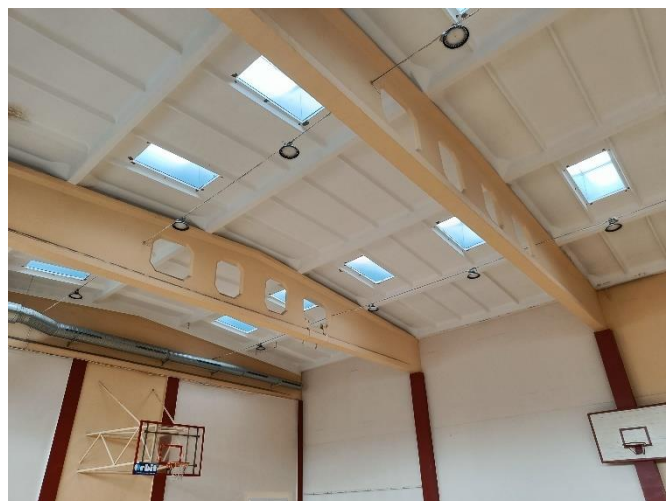
20 pav. Sporto salės denginys įrengtas iš surenkamų briaunotų g/b plokščių, kurios atremtos ant gelžbetoninių surenkamų dvitėjinio skerspūvio sijų.
